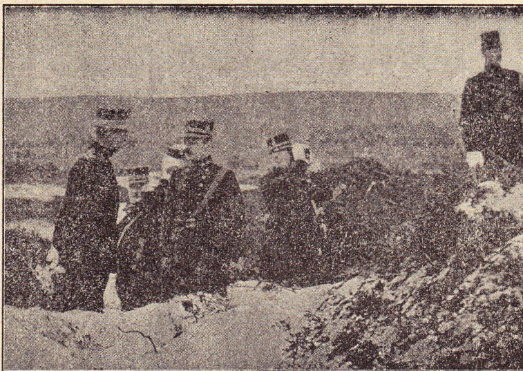
Le Roi Albert dans une tranchée.
